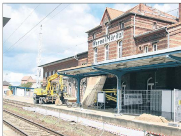
Eine Abrissfirma hat die Bahnsteigüberdachung am Warenaer Bahnhof demontiert. Der Bahnsteig soll normgerecht für heutige Züge umgebaut werden und so das barrierefreie Ein- und Aussteigen ermöglichen. Foto: B. Wüstemann
